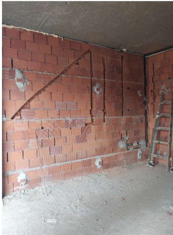
Instalaciones Sanitarias e Instalaciones eléctricas en N1
