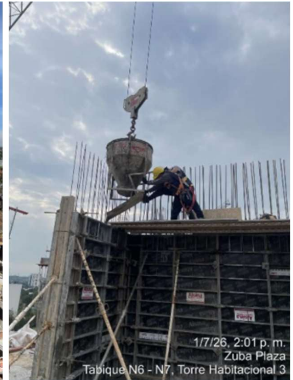
Cargamento Losa N6 – Encofrado y armador de losa N6 - Cargamento de pilares N6-N7
